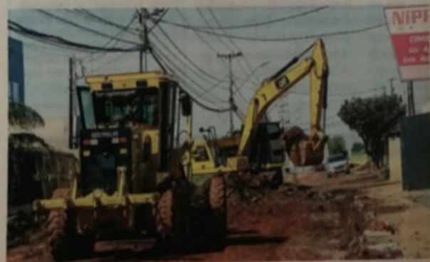
Máquinas retiram capa asfáltica para alargamento do trecho
